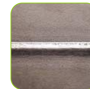
Aspecto da face da solda junta topo a topo aço inox esp. 6mm.
